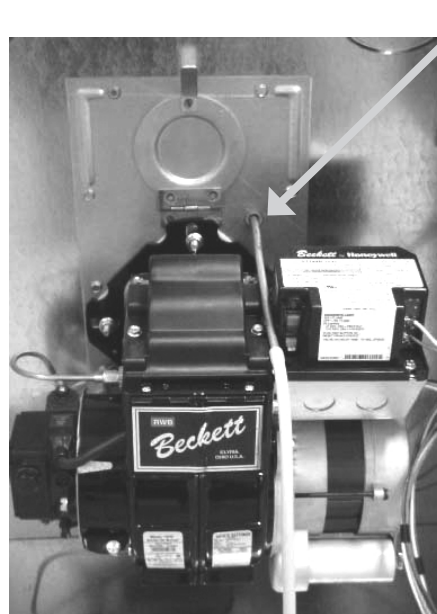
Figure 2 : Vérification de l'apport d'air secondaire au-dessus de la couche en ignition
